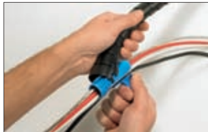
Вставьте приспособление для монтажа с одного конца кабельного кожуха Helawrap.
