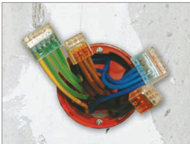
Огромное многообразие коннекторов от 2 до 8 контактов поставляется в зависимости от области применения. Прозрачный корпус позволяет быстро и легко проверить качество соединения.
